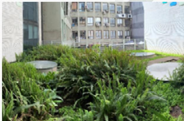
*Imagen 64 Cubierta semi-intensiva. Edificio Anid, Santiago de Chile. Profundidad de sustrato 11 cm.*
