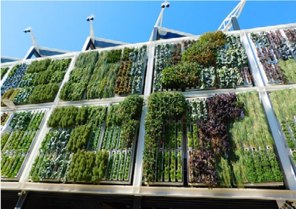
*Imagen 75: Sistema Muro Verde con Enredaderas en Estructura (a y b. <https://ecoosfera.com/2017/09/hacer-muro-verde-en-casa-te-mostramos-3-ideas-faciles>)*
