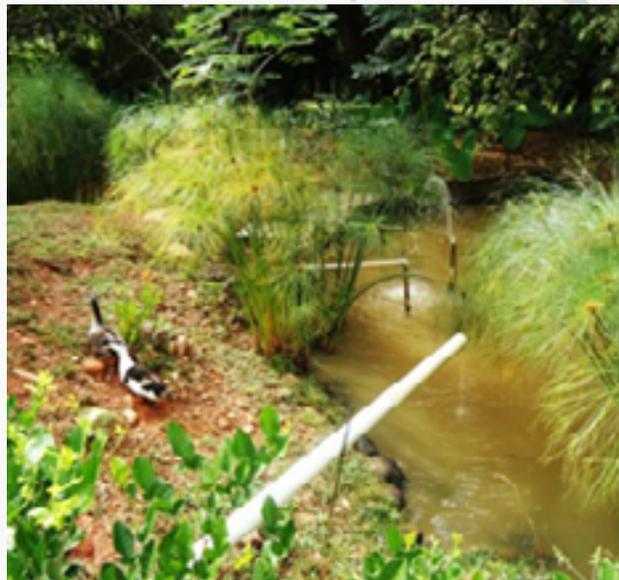
*Imagen 09 Estanque de Almacenamiento Aguas Grises tratadas. Proyecto "Fitodepuración". <https://paissano.wordpress.com/proyectos-ejecutados/proyectos>*
