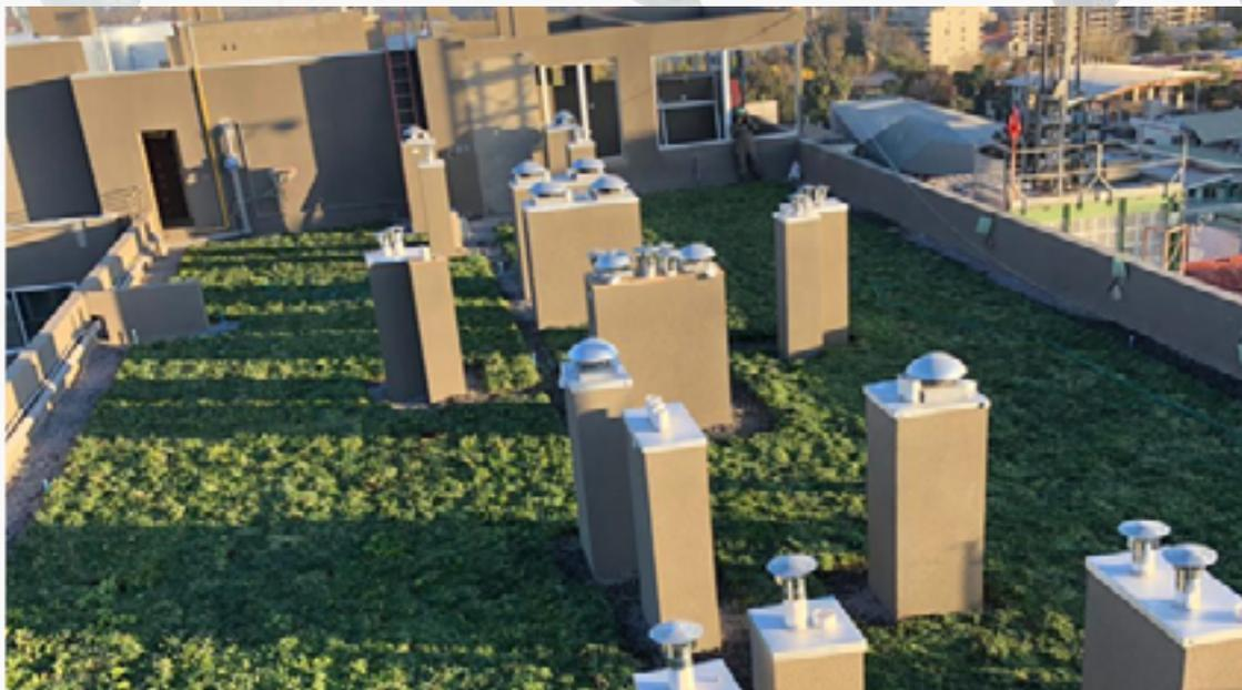
*Imagen 61: Cubierta Extensiva, Edificio Mix, Ñuñoa Santiago de Chile. Sistema Modular LiveRoof - VerdeActivo.*
