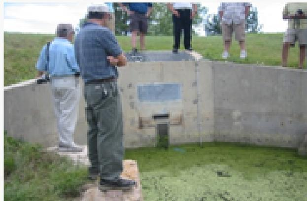
*Imagen 27: Medidas de control local: estanques de detención (cortesía de Larry Roesner)*
