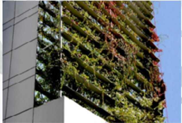
Imagen 55: Sistema de estructura para plantas trepadoras. Edificio Consorcio. <https://www.disenoarquitectura.cl/edificio-consorcio-santiago-de-enrique-browne-y-borja-huidobro/>
