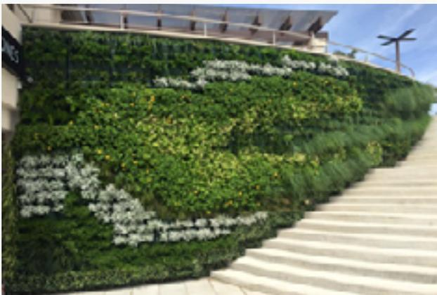
*Imagen 53: Muro verde exterior con sistema modular. Foto Minigarden México.*
