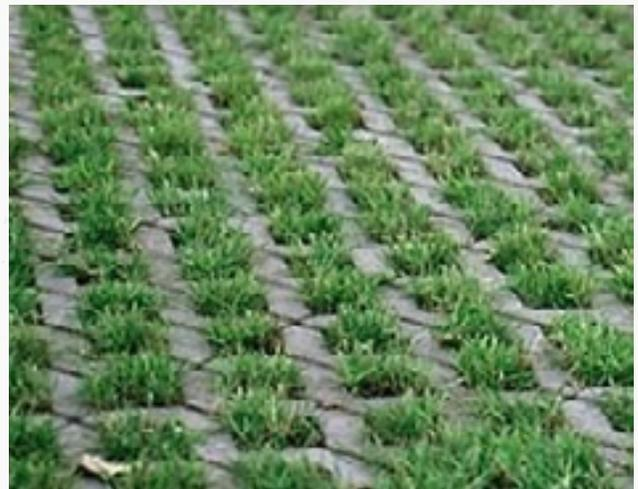
Imagen 46: Pavimentos impermeables con relleno permeable,
