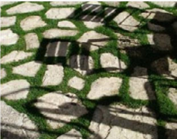
Imagen 45: Bloques impermeables con uniones permeables,
