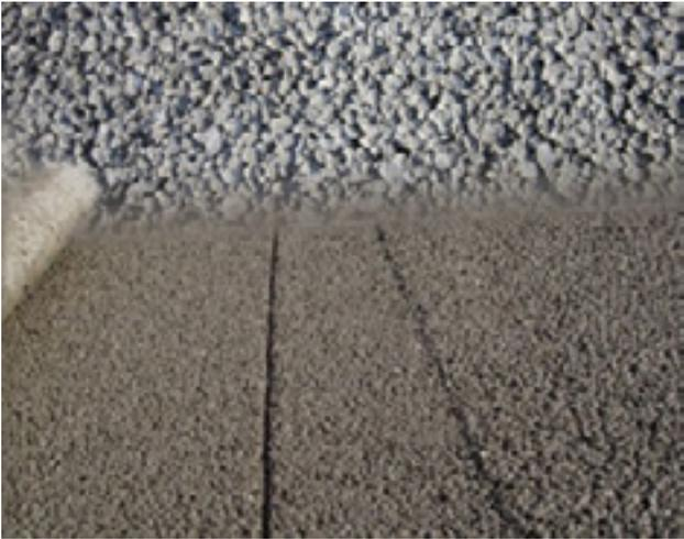
Imagen 43: Pavimento de mezcla porosa,
