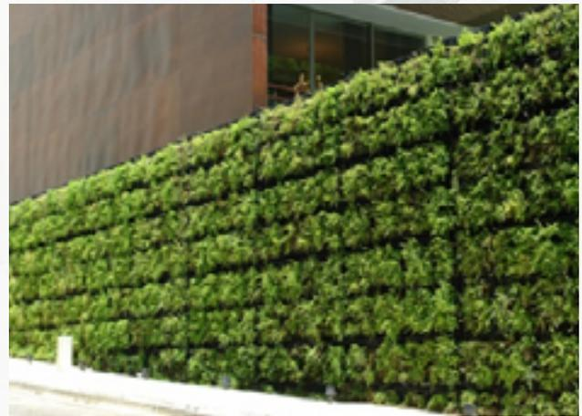
*Imagen 73: Sistema Modular con Sustrato (a y b). <http://blog.is-arquitectura.es/2012/01/07/tournesol-vgm-sistema-modular-de-muros-vegetales>*
