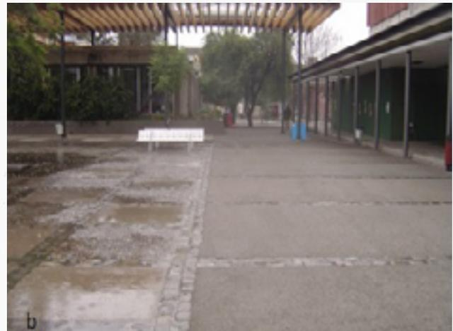
Imagen 26: Medidas de control en la fuente: (a) techo verde ([www.brooklynfeed.com/2010/05/green-roof](http://www.brooklynfeed.com/2010/05/green-roof)), (b) pavimento poroso en Ingeniería UC, Campus San Joaquín.
